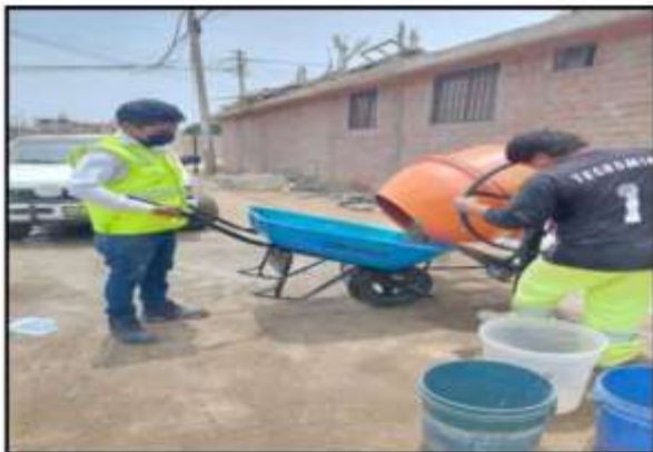
Figura N° 4: Toma de Muestra para Elaboración de Probetas 4"x8" de concreto.
