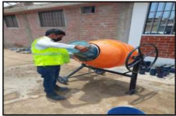
Figura N° 3: Dosificación de agregados para preparación de Propuestas I, II, III, IV de Concreto f'c=210\text{Kg}/\text{cm}^2
