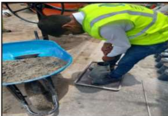
Figura N° 6: Elaboración de Slump, para corroborar el asentamiento
