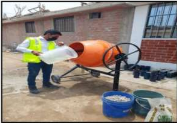
Figura N° 2: Dosificación de agua para preparación de Propuestas I, II, III, IV de Concreto f'c=210\text{Kg}/\text{cm}^2
