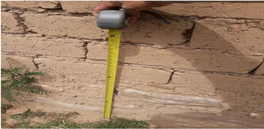
FOTOGRAFÍA N° 09: Medición del sobrecimiento compuesto de piedras y barro en las vivienda de dos niveles en adobe en la parcialidad de Japisse del centro poblado Mallco- Puno.
