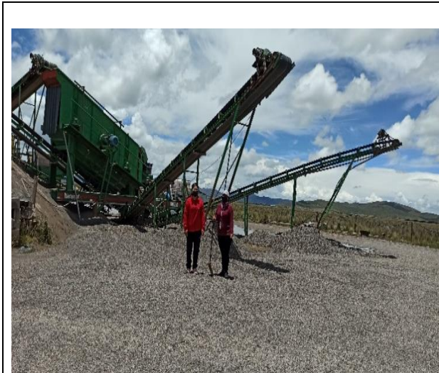
FOTO N°01: Ubicacion Piedra Azul- Juliaca - Arequipa km 4+00
