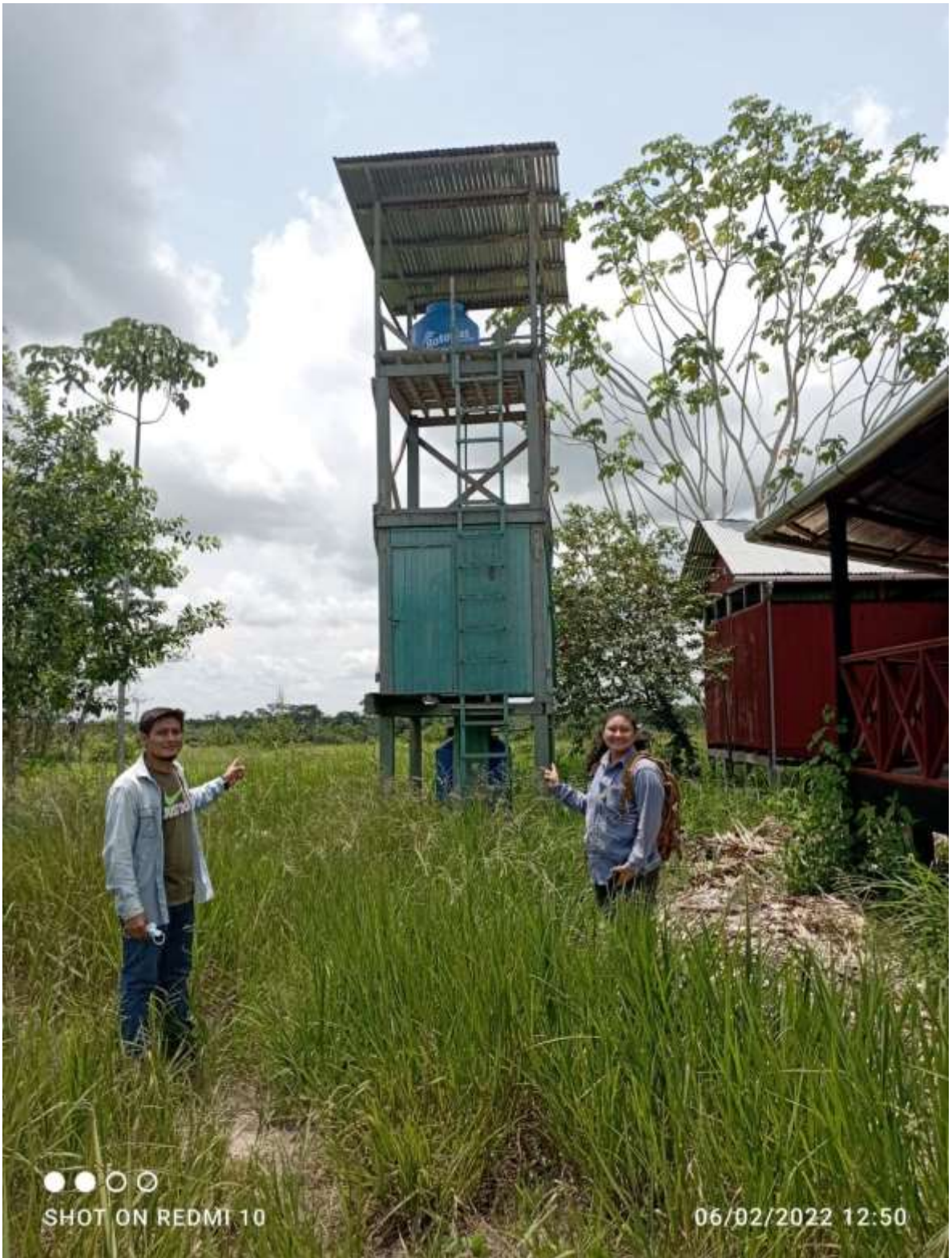
Figura 16: En la imagen observamos el castillo de madera del reservorio fuera de uso de la Comunidad Nativa Santa Clara.
