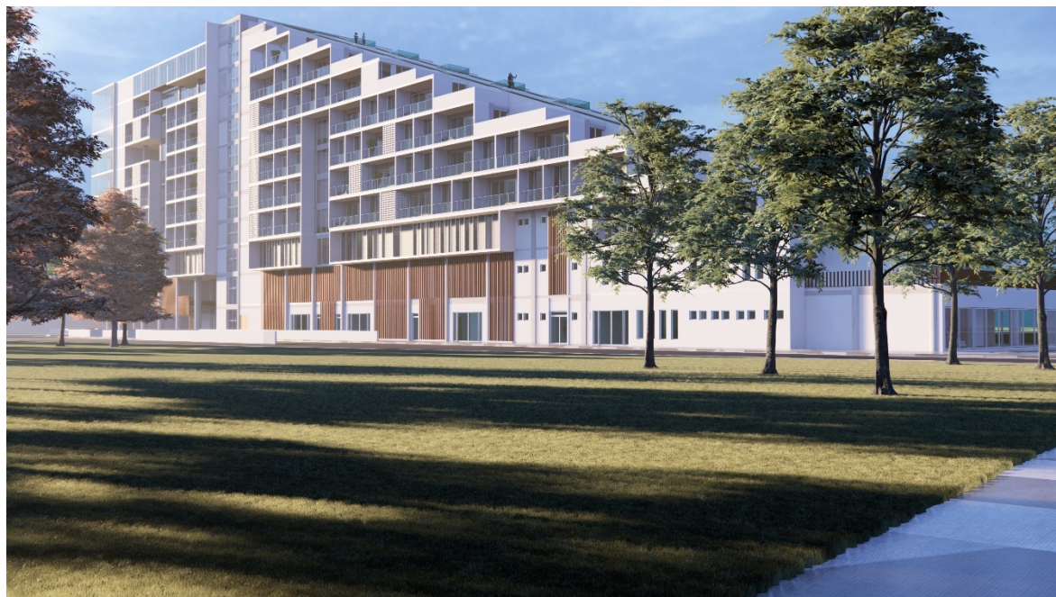
Figura 70. Vista exterior de torre del sector A
