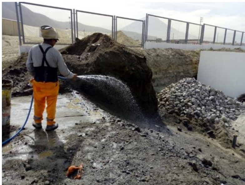
Figura 26. Mitigación ambiental (obras y edificaciones) en la constructora PALKIA E.I.R.L
