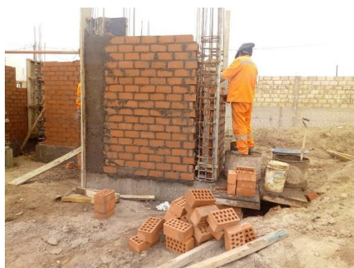
Asentado de ladrillo
