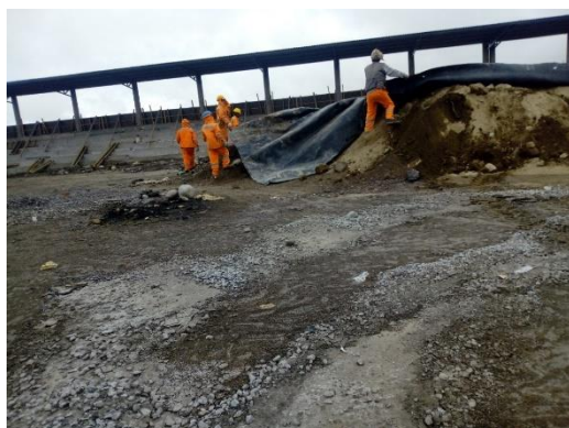
Instalación de poza provisional – Enmallado
