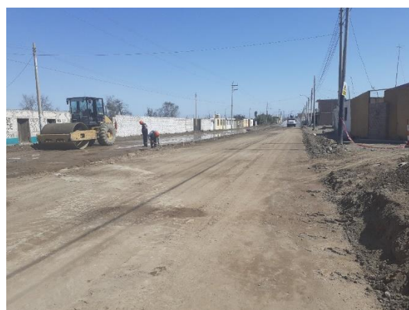
Compactado de subrasante
