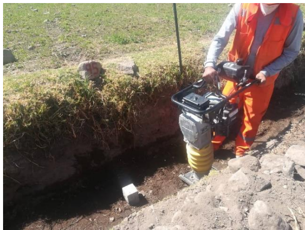
Conformación con material propio
