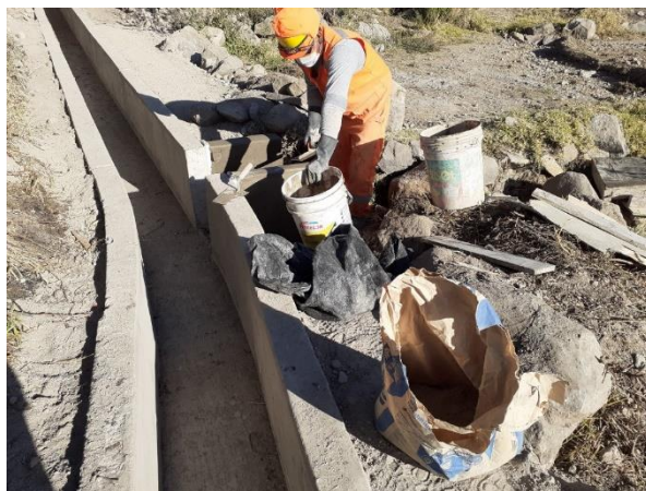
Solaqueo de muros en canal
