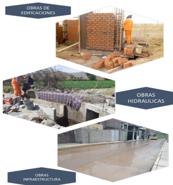
Figura 11. Tipos de obras
