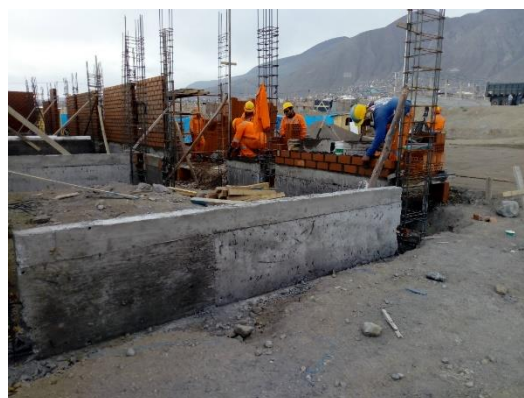
Asentado de ladrillo y sobrecimiento
