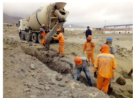
Vaciado de cimiento corrido
