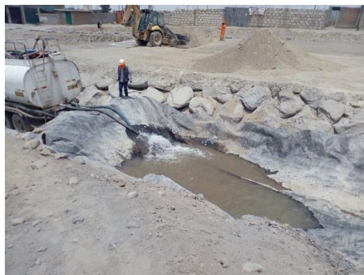
Instalación de poza provisional – Infraestructura
