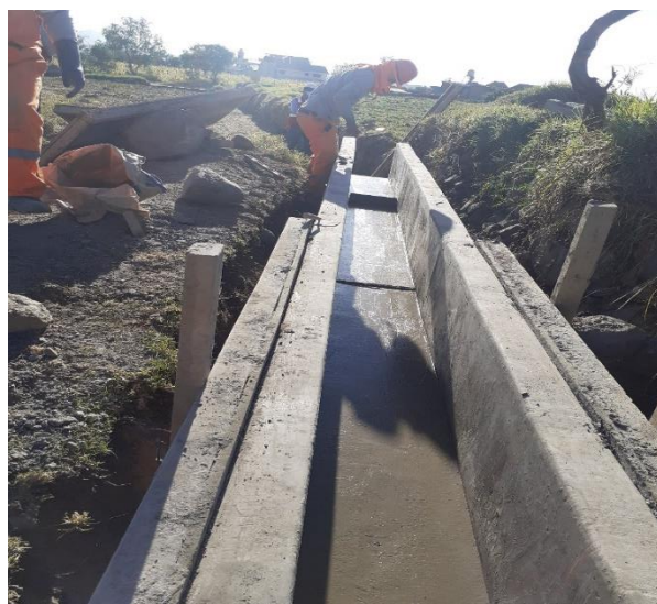
Acabado de piso de canal
