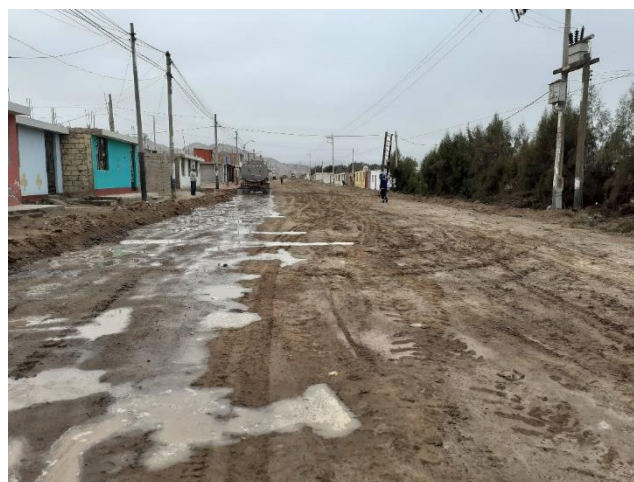
Riego de subrasante
