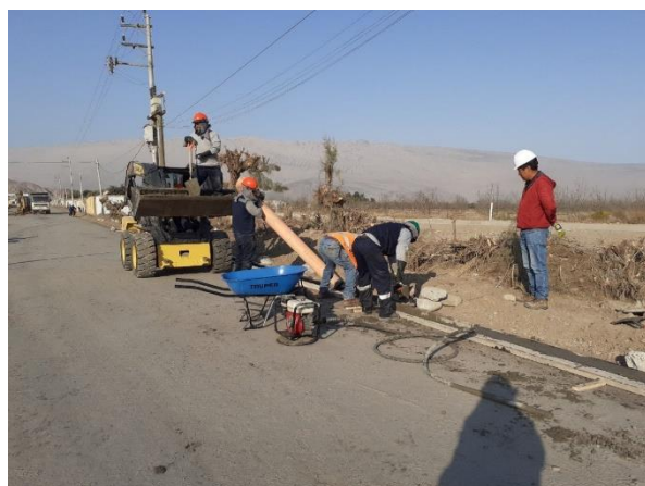
Vaciado de sardineles
