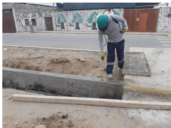
Curado de concreto con aditivo
