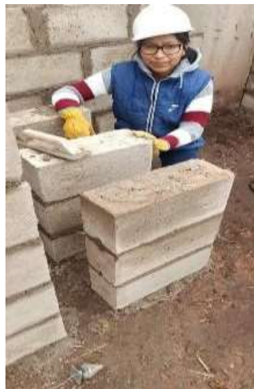
Figura 7: Elaboración de pilas de bloquetas
