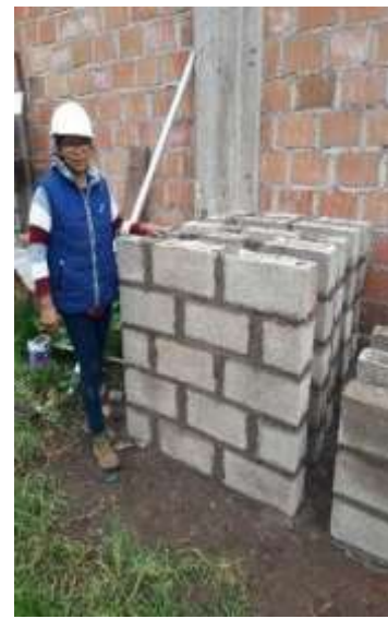
Figura 8: Elaboración de muros de bloquetas
