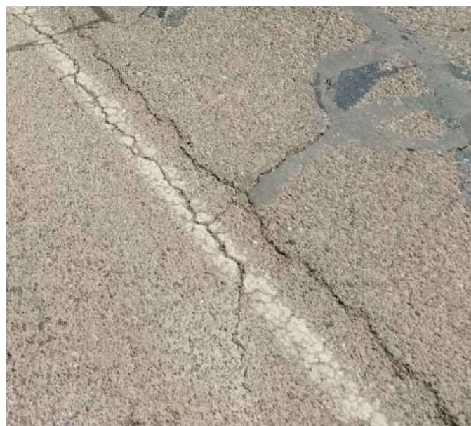
Fotografía 04. Identificación de Daños grieta longitudinal y transversal
