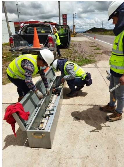
Figura 30: Instalación de la viga Benkelman
