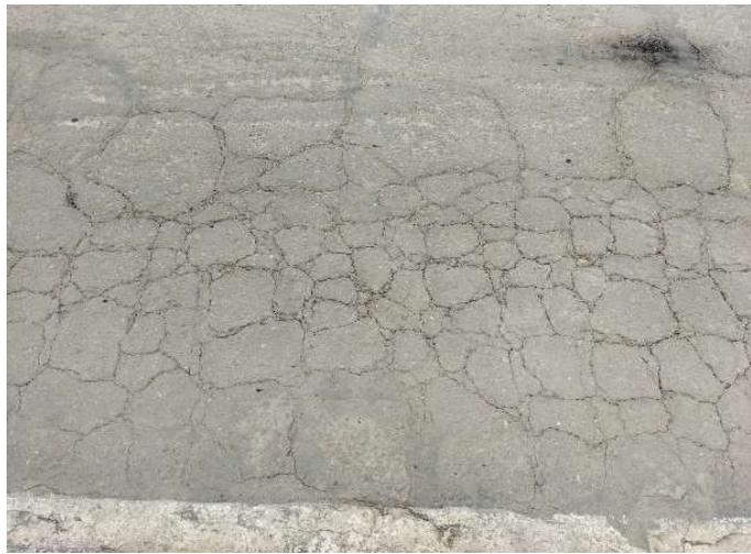
Fotografía 03. Identificación de Daños Piel de Cocodrilo
