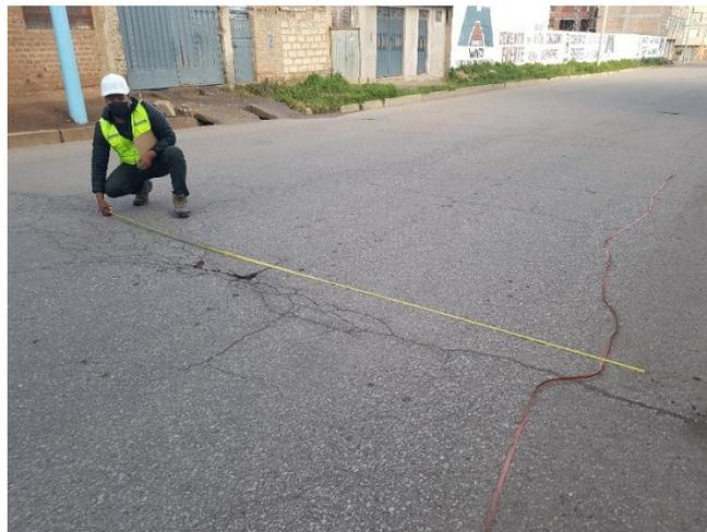
Figura 10. Identificación de grieta transversal
