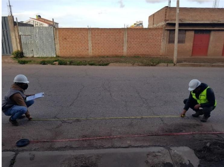
Figura 15. Identificación de agrietamiento en bloque
