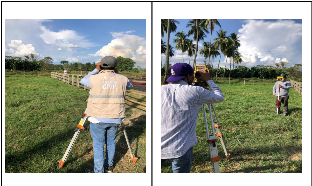
Figura 23 y 24: En las imágenes se puede observar el levantamiento topográfico del terreno.
