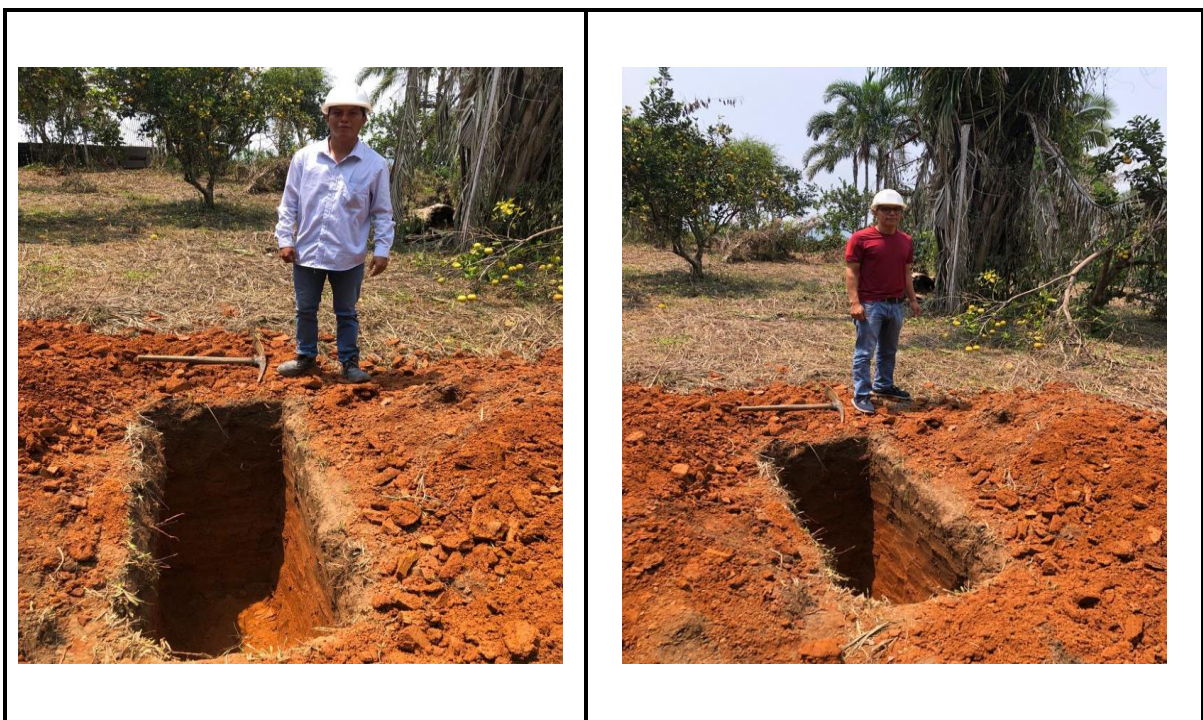
Figura 25 y 26: En las imágenes se puede apreciar la vista preliminar de la elaboración de la calicata.
