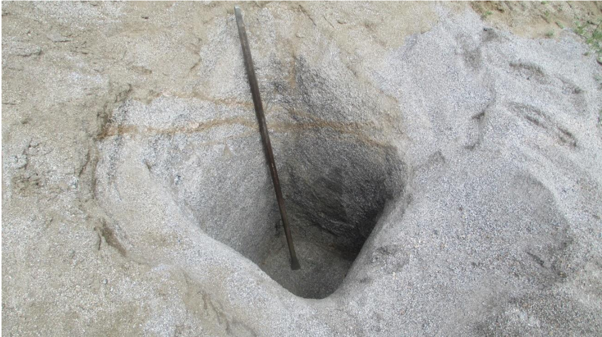
Excavación de calicata N° 1.
