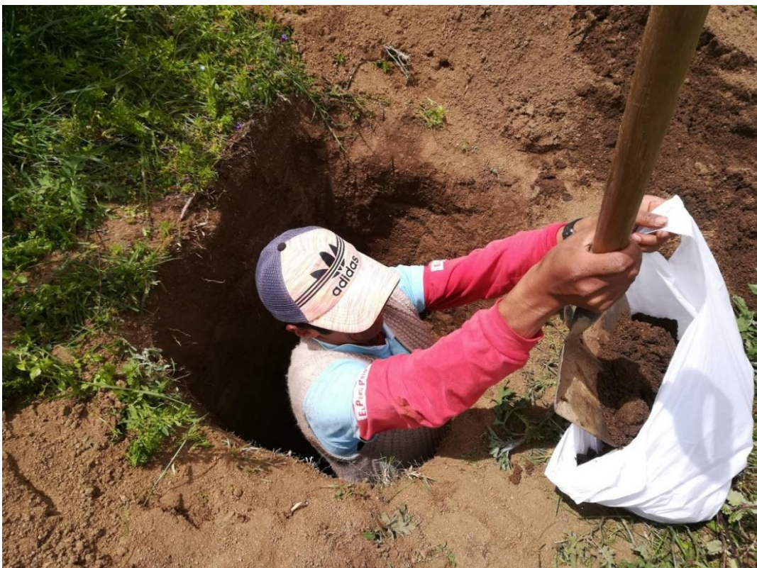
Obtención de muestra de calicata N° 2.
