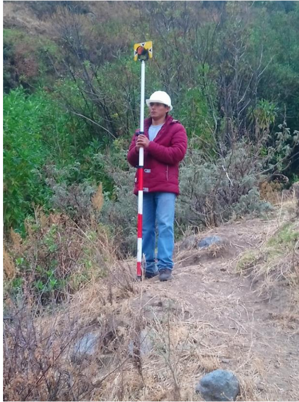
Levantando la franja de terreno donde se diseñará la carretera.
