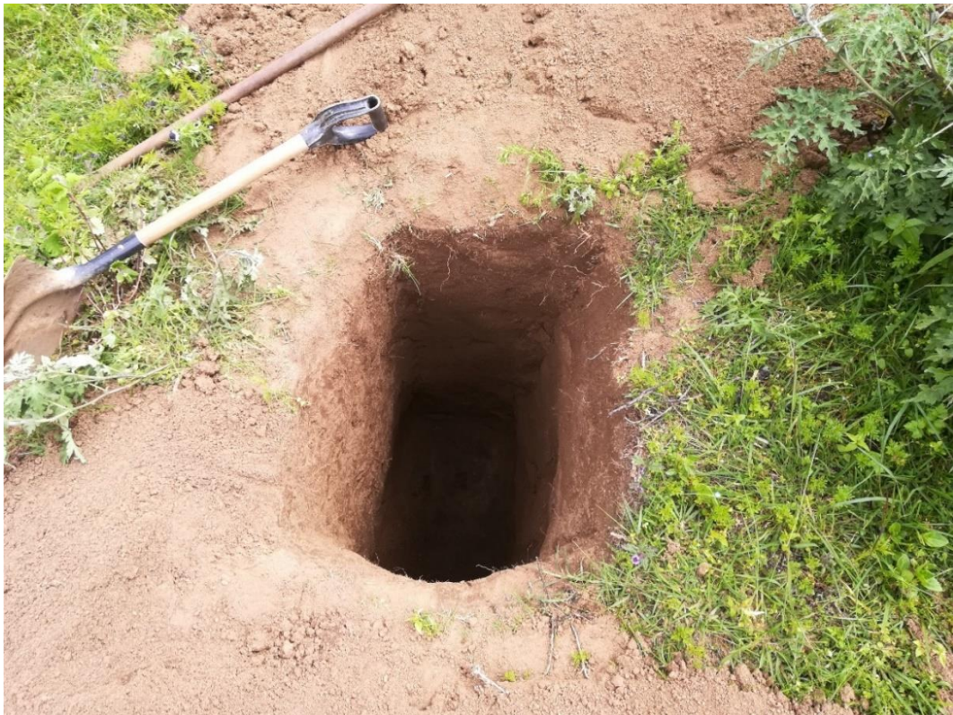
Excavación de calicata N° 2.
