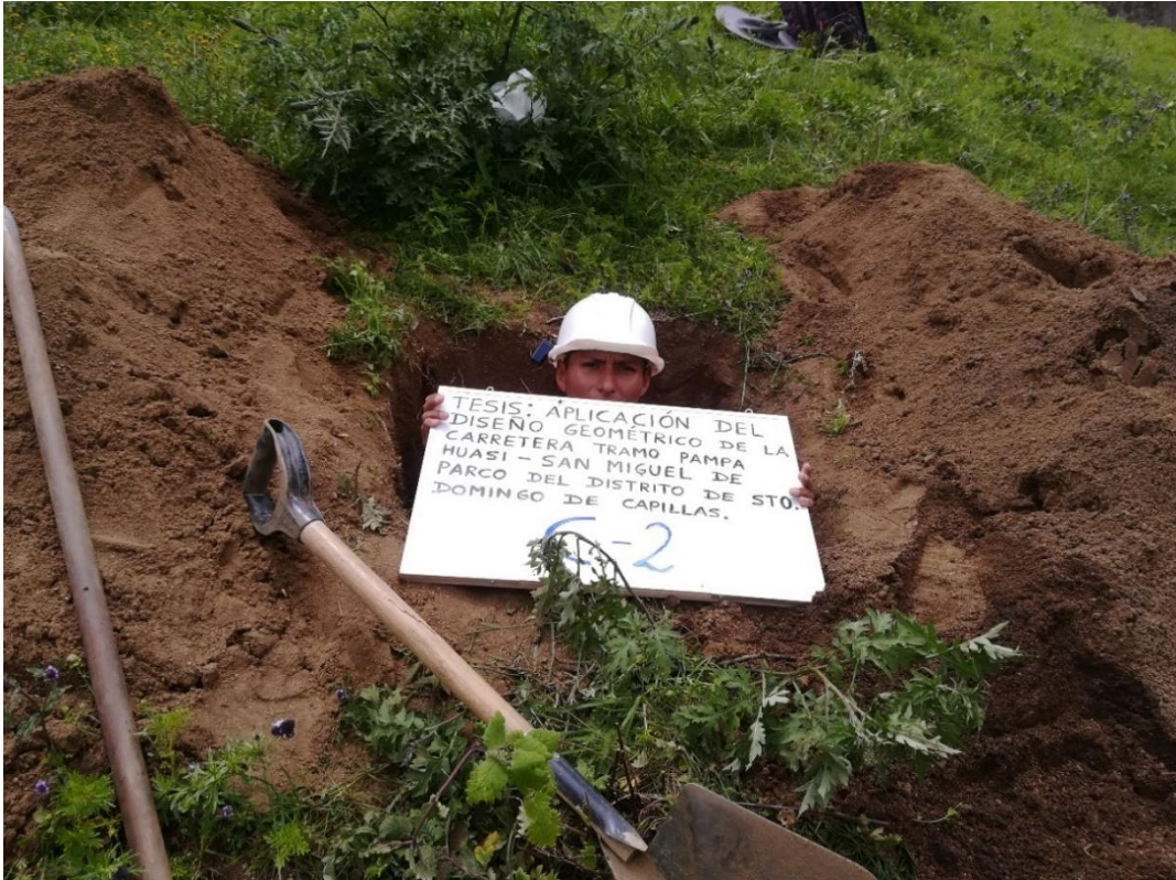
Identificación de calicata N° 2.
