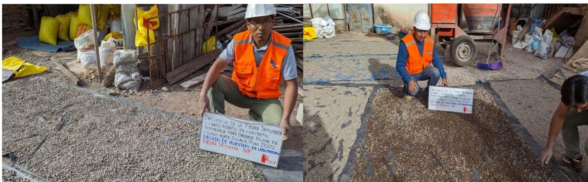
Figura N° 06: Proceso de secado de los agregados.
