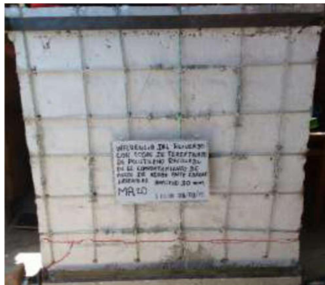
Foto 06: Resultado de la fase 3 del MCR20 P E, se aprecia una fisura en la base.
