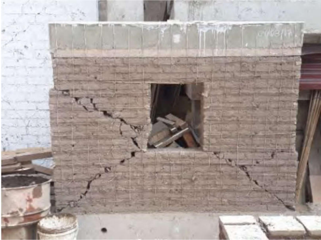
Foto 13: Ensayo carga cíclica lateral, se aprecia el final del muro MCR D E después de la fase 10, fin del ensayo, la foto es tomada después de haber retirado el revoque de toda la estructura.
