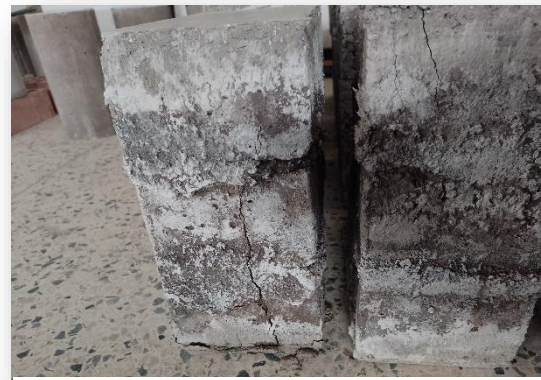
Figura 3. 41 grieta en la pila de albañilería
