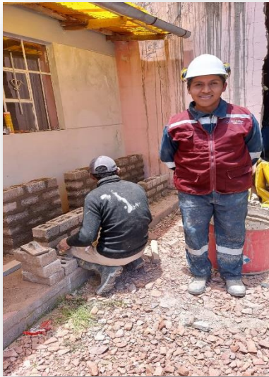
Figura 3. 43 Elaboración de los muretes con las dosificaciones con PET reciclado (0%, 3%, 6% y 9%)
