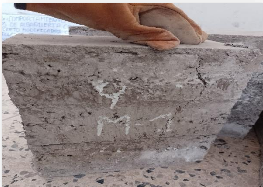
Figura 3. 42 grieta en la pila de albañilería
