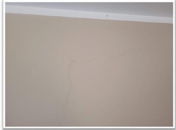
*GRIETAS MENORES A 2mm ENCONTRADAS EN MUROS DE ALBAÑILERÍA*
