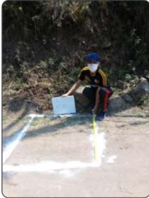
Figura 24. Marcación con yeso de la calicata C-1.
