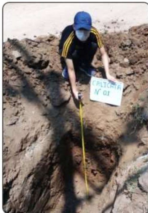
Figura 31. Medición de la profundidad de la calicata C-1. Fuente: Elaboración propia.
