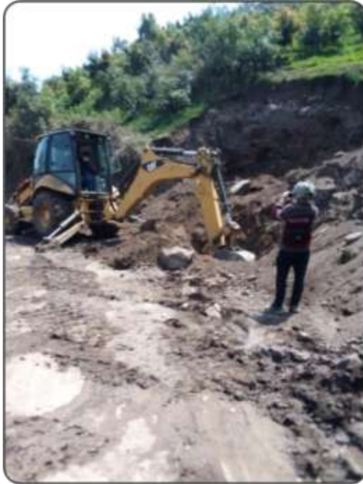
Figura 28. Excavación con retroexcavadora la calicata C-2. Fuente: Elaboración propia.
