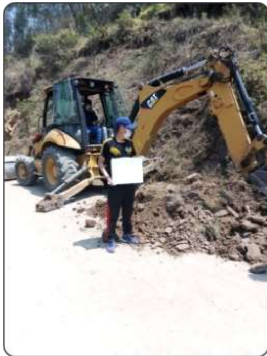
Figura 27. Excavación con retroexcavadora la calicata C-1. Fuente: Elaboración propia.
