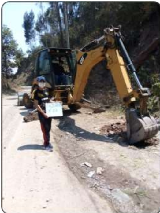
Figura 29. Excavación con retroexcavadora la calicata C-3.
