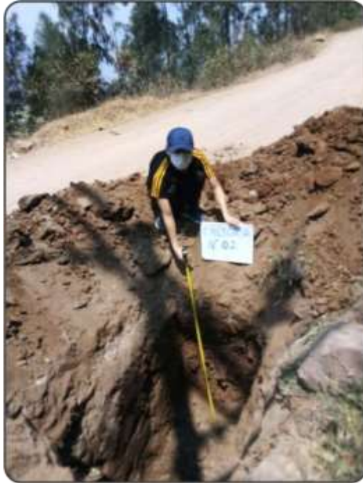
Figura 32. Medición de la profundidad de la calicata C-2. Fuente: Elaboración propia.
