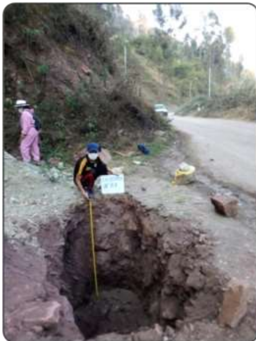
Figura 33. Medición de la profundidad de la calicata C-3. Fuente: Elaboración propia.
