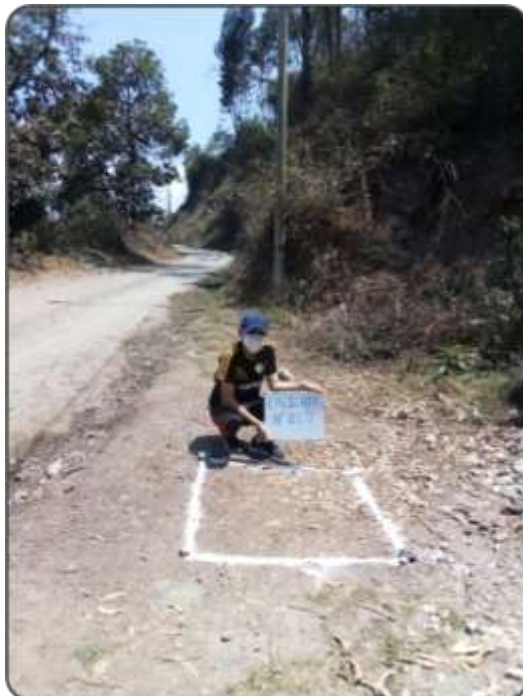
Figura 25. Marcación con yeso de la calicata C-2.
