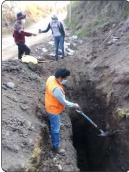
Figura 30. El técnico laboratorista perfilando manualmente con pala la calicata. Fuente: Elaboración propia.
