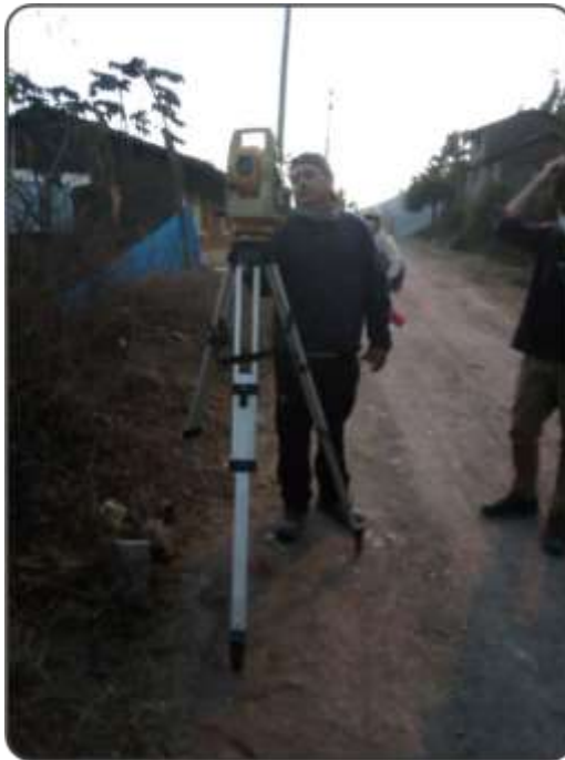
Figura 19. Topógrafo manipulando la estación total en la carretera Abancay - Huayllabamba.
