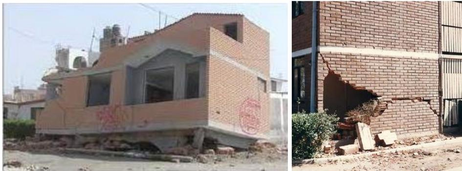
*Figura 1. Colapso de vivienda y muro de albañilería.*
