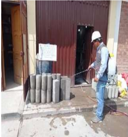
Figura 15. Curado por Aspersión o rociado.
