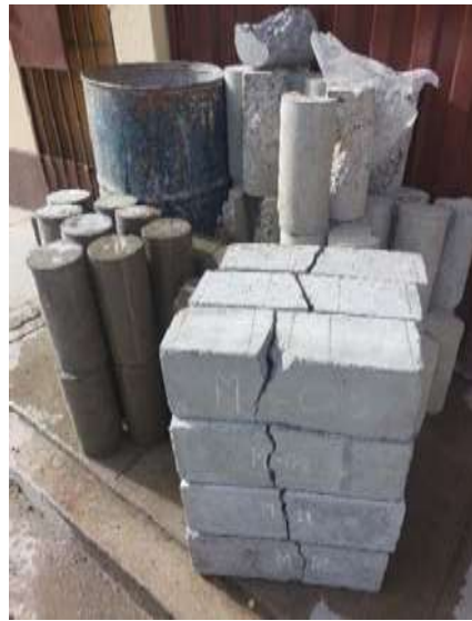
Figura 20: Muestra de vigas de concreto fracturadas f'c=210 \text{ Kg/cm}^2 y f'c.=280\text{Kg/cm}^2 .
