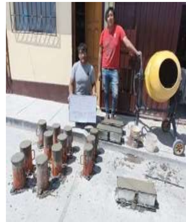
Figura 14. Vaciado de la mezcla concreto.
