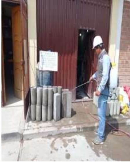
Figura 05: curado por aspersión de probetas y vigas de concreto.
