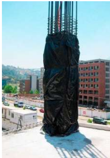
Figura 3. Curado con películas plásticas
