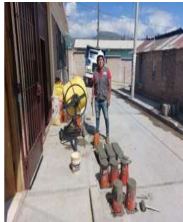
Figura 13. Llenado y chuseado de las probetas y vigas.
