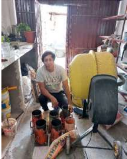
Figura 01: Preparación de los moldes para la elaboración del concreto para f'c=210 \text{ Kg/cm}^2 y f'c.=280\text{Kg/cm}^2 .
