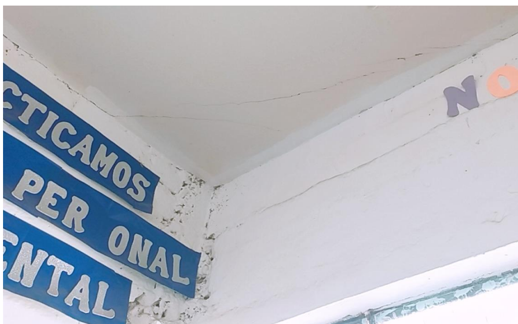
Presencia de grietas y fisuras en muros y losa
