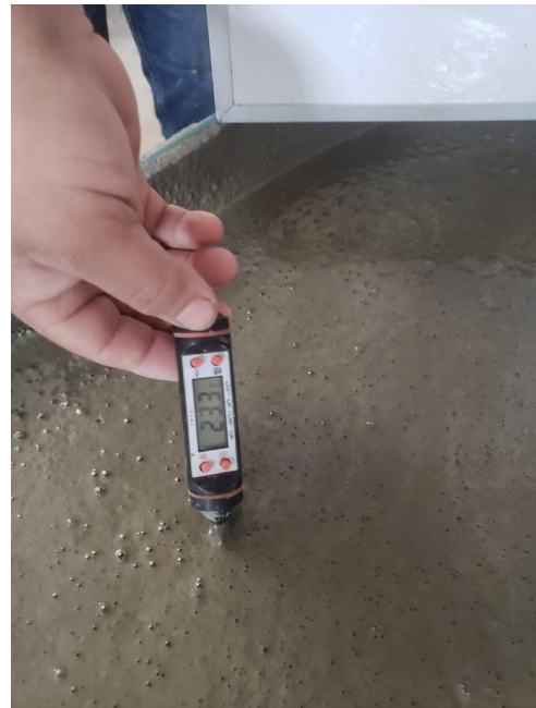
Foto 8: Cálculo de temperatura del concreto
