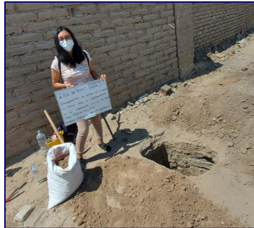
Foto 04: Extracción de muestra de la calicata 01
