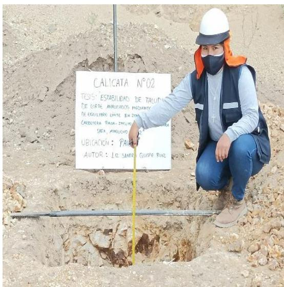
Figura 2. Excavación de calicata
