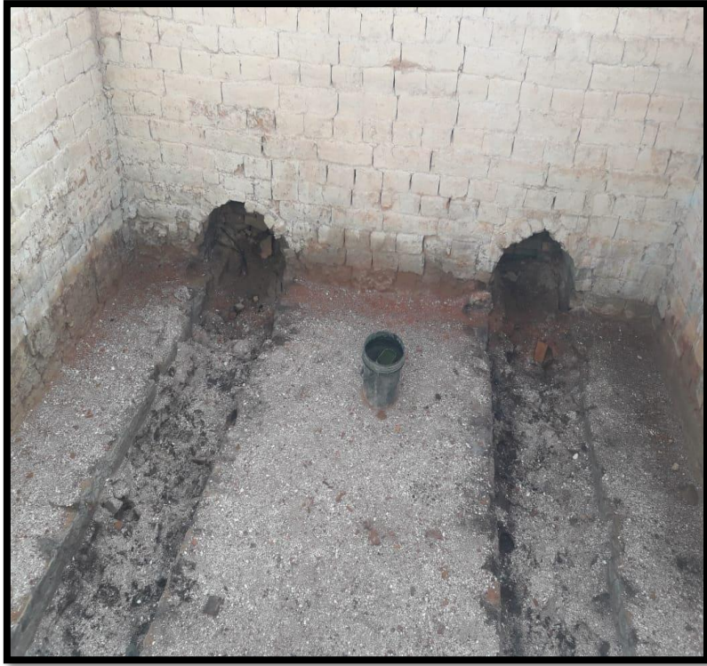
FIG.04 SE OBSERVA EN LA IMAGEN EL HORNO DONDE SERAN QUEMADOS LOS LADRILLOS
