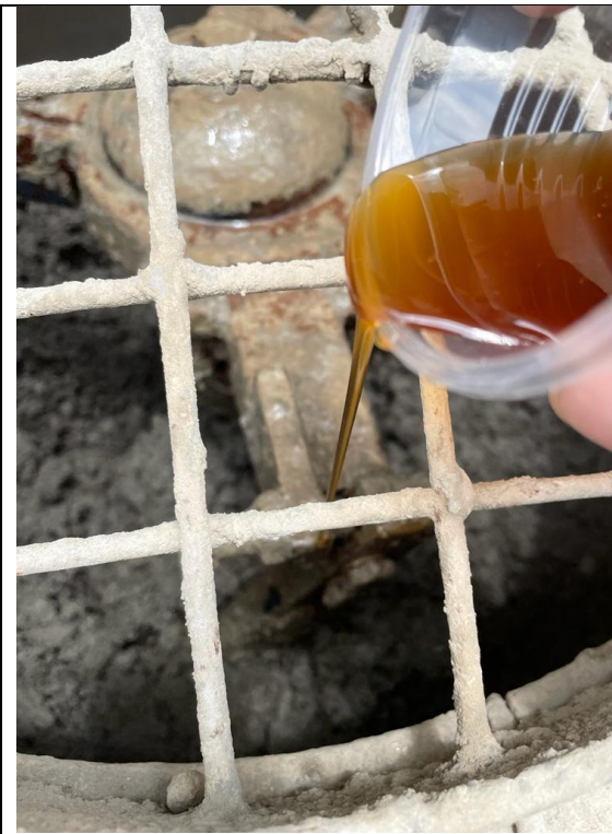
Adicion de aditivo
