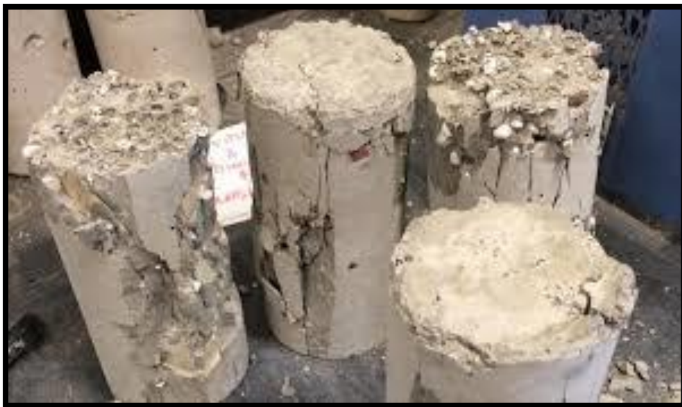
Figura 7. Falla de rotura de concreto.
