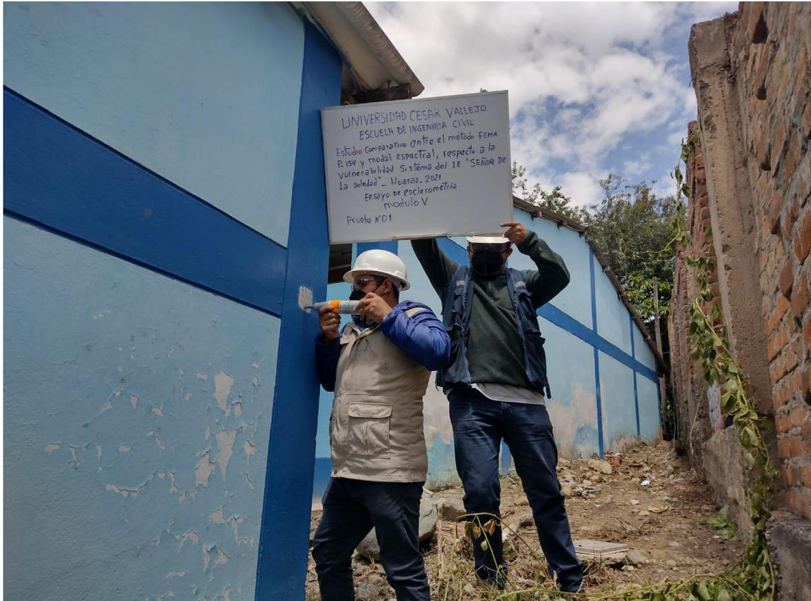
Figura 38: aplicación de los 10 disparos por prueba de esclerometría
