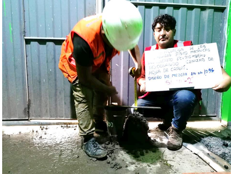
Figura 8. Asentamiento del concreto
