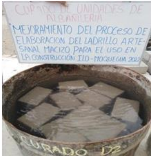
Figura 39. Curado por inmersión en ladrillos macizos
