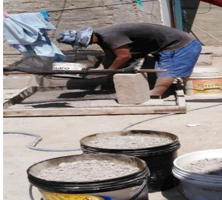
Figura 14. Zarandeo de material de concreto reciclado
