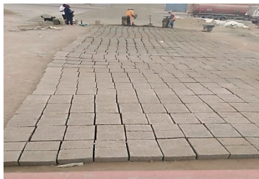
Figura 10. Ladrillos expuestos a la intemperie
