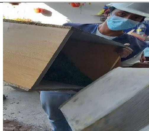
Foto 12. Incorporando vidrio a la mezcla de concreto
