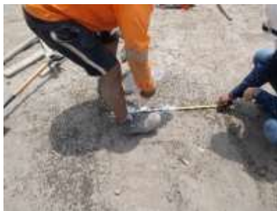
Anexo 16. Marcando el perímetro de la calicata, con la ayuda de la wincha y el yeso.
