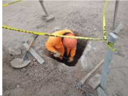
Anexo 8. A medida del avance, se puede visualizar la mitad de la excavación de la Calicata 01.
