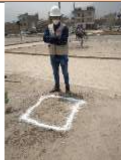
Anexo 17. Se puede observar, la marcación final de la calicata a excavar 1.50 m de profundidad.
