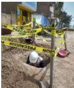
Anexo 11. Durante la ejecución de la Calicata, pude excavar cierta profundidad en la calicata.
