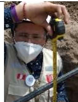
Anexo 12. Se alcanzo a la excavación mínima requerida por el MTC de 1.50m de profundidad, con el apoyo de la herramienta barrote.
