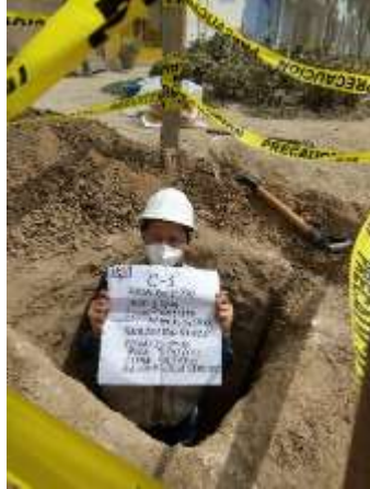
Anexo 13. Se cumplió con la excavación requerida en base a la norma.
