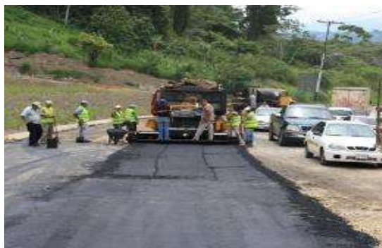
Figura 8. Estabilización con asfalto
