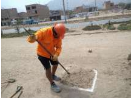
Anexo 7. Ahora comenzamos con la excavación de la Calicata 01, con el apoyo de la herramienta barreta.
