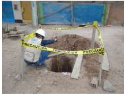
Anexo 10. Se puede reflejar, que optamos la seguridad de los transeúntes, es por ello que se colocó una cinta de precaución de seguridad alrededor de la calicata.
