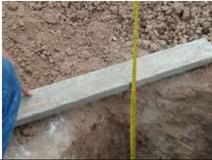
Anexo 9. Se puede observar, con la ayuda de la wincha y esencialmente una regla para poder guiarnos a cuanto altura estamos de profundidad de calicata.
