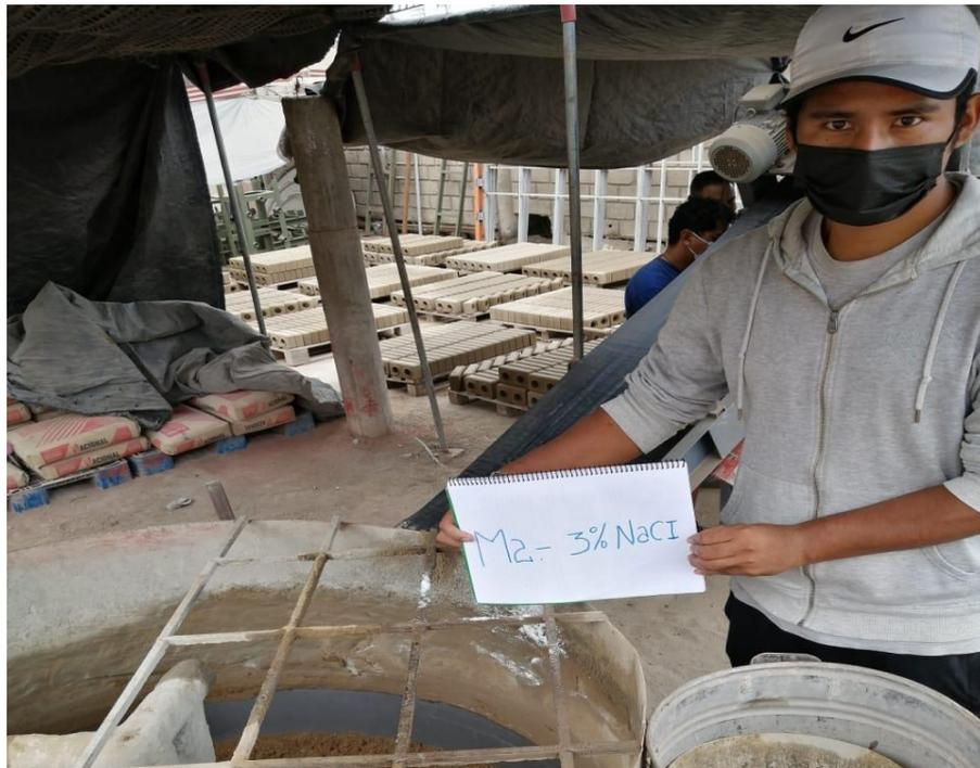
Foto 6. Preparación de la mezcla 2 con 3%NaCl
