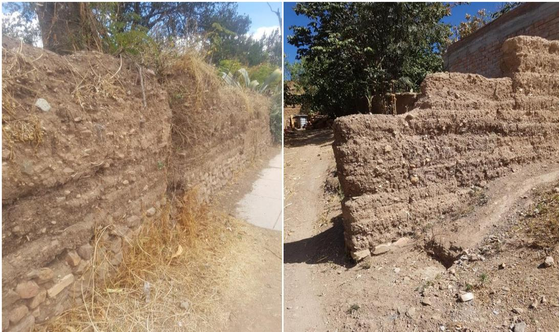
*Figura 1.* Cercos deteriorados por la lluvia en el distrito de Luricocha.
