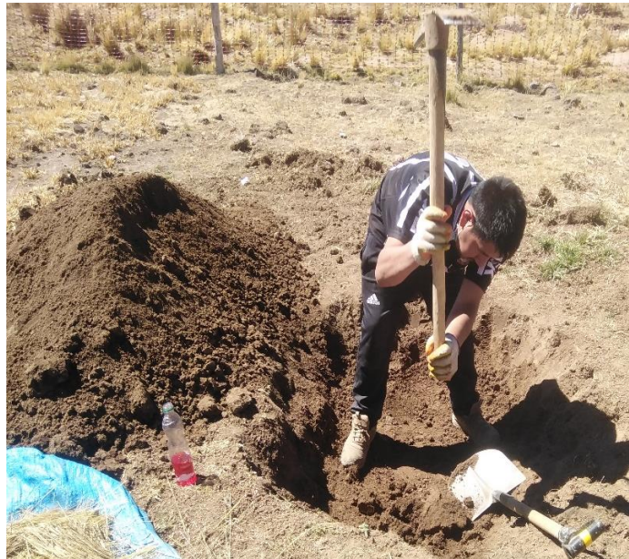
Figura 6. Extracción de tierra para la elaboración de adobe
