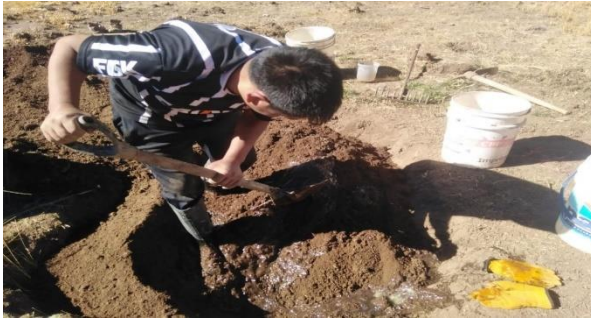
Figura 11. Batido del barro y el mucilago de huaraco
