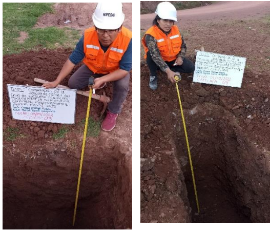
Foto 09. Calicatas C-03. Km 4+650, C-04. Km 6+050.
