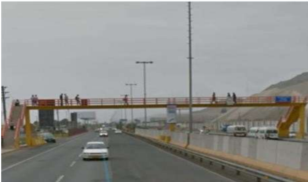
Figura 12: Vista panorámica del puente peatonal San Luis. Fuente: Elaboración propia.
