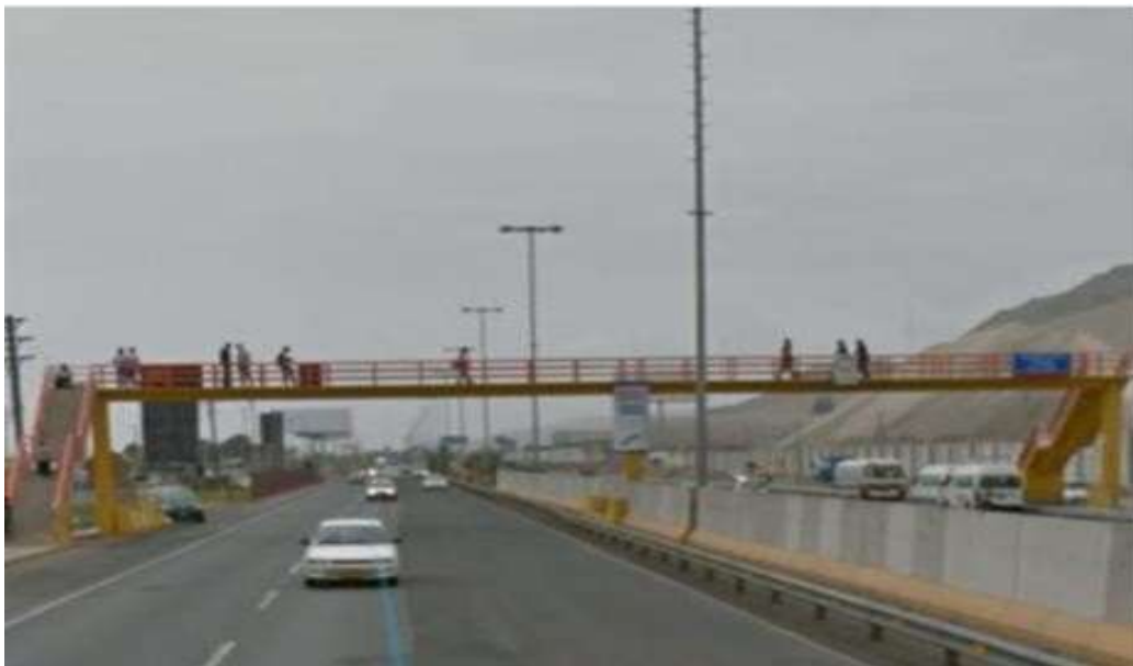
Figura 15: Vista panorámica del puente peatonal bajo estudio. Fuente: Elaboración propia.
