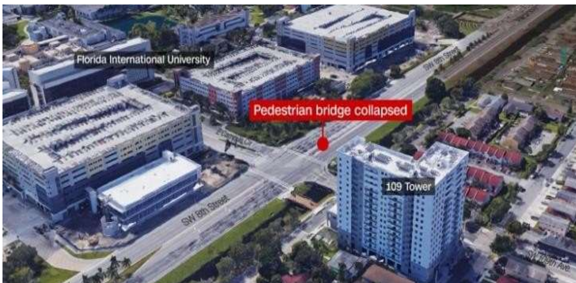
Figura 2: Ubicación espacial del puente Pedestrian.
