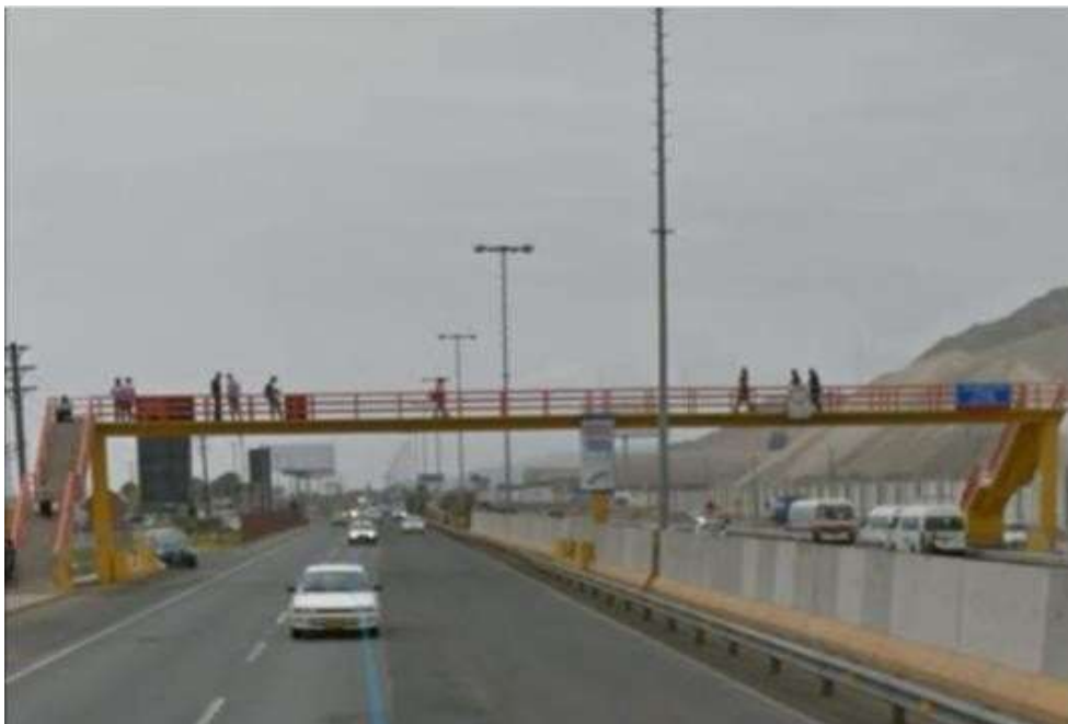
Figura 4: Vista panorámica del puente peatonal San Luis. Fuente. Elaboración propia.
