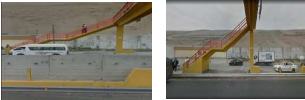
Figura 17: Escalera derecha y conexión de columna a viga. Fuente: Elaboración propia.
