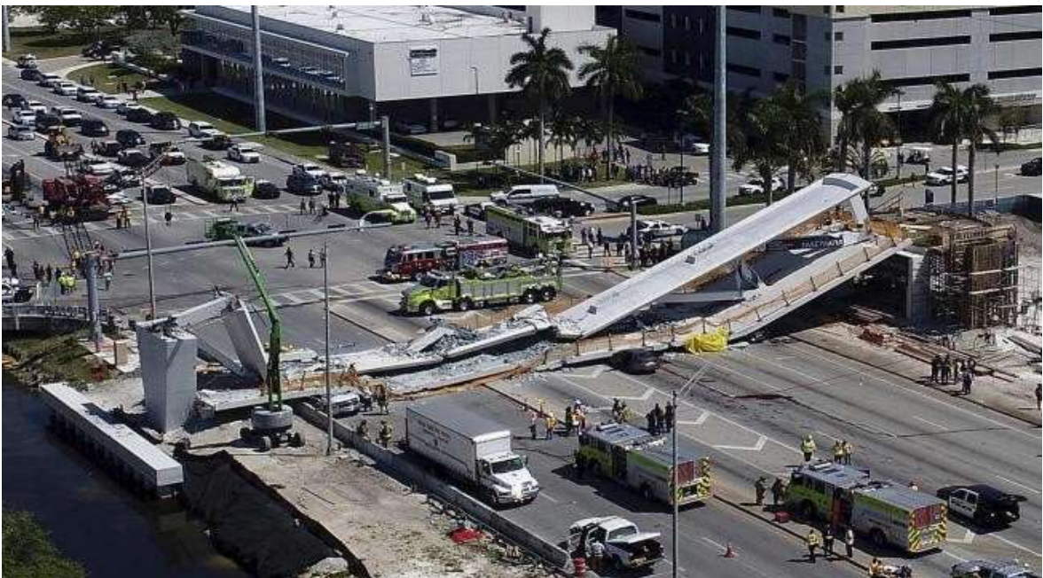
Figura 1: Colapso del puente peatonial Pedestrian en los Estados Unidos de Norteamérica.
