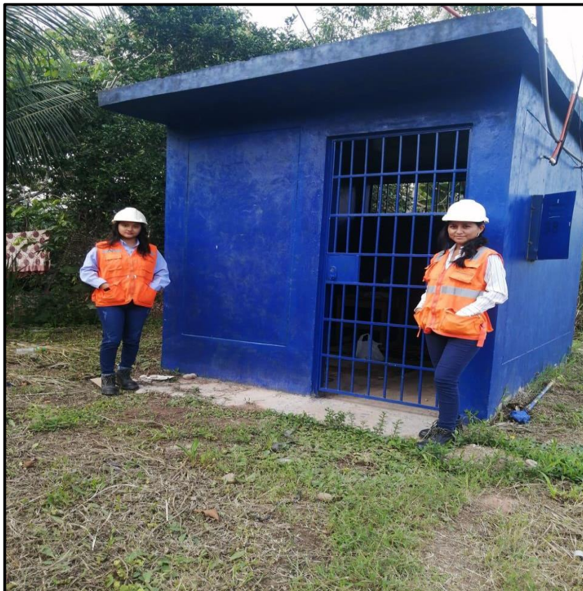
Figura 3: Foto del centro de maquinas
