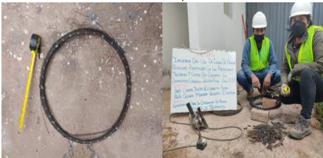
Figura 43. Corte del Acero del Neumático a 3 – 3.5 cm aprox.
