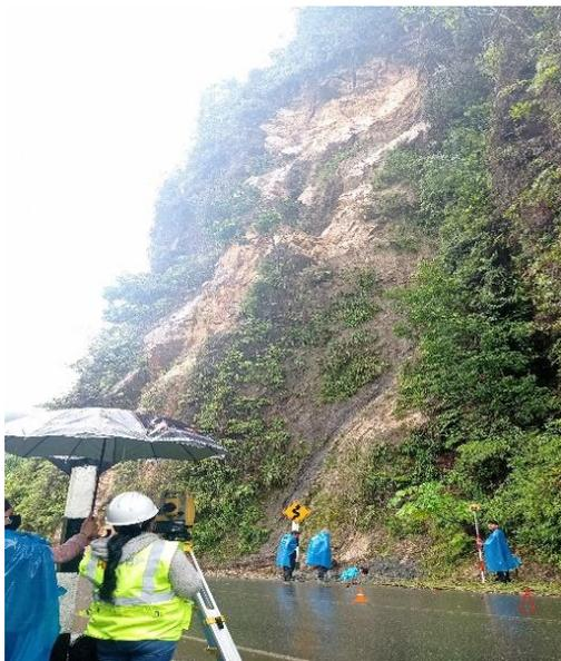
**Figura 10.** Levantamiento topográfico del talud km 330+792 al km 330+835
