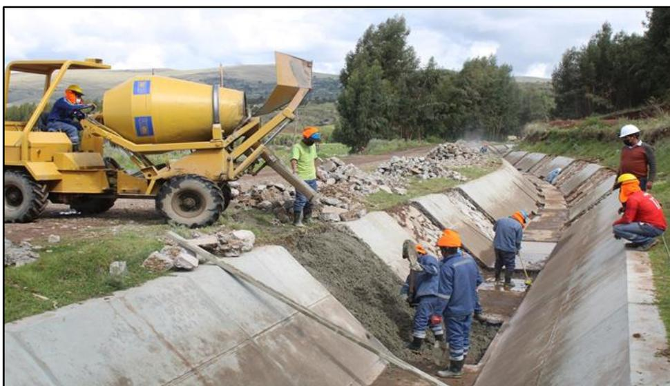
**Figura 3.** Trabajos de mantenimiento del personal de OPEMAN
