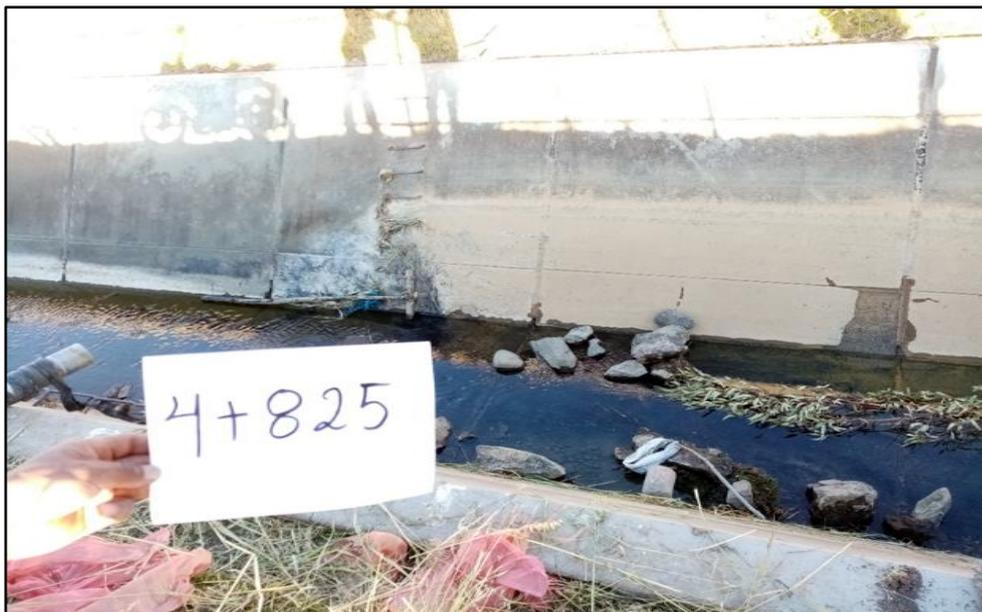
**Figura 9.** Canal alimentador con deficiencias en mantenimiento.
