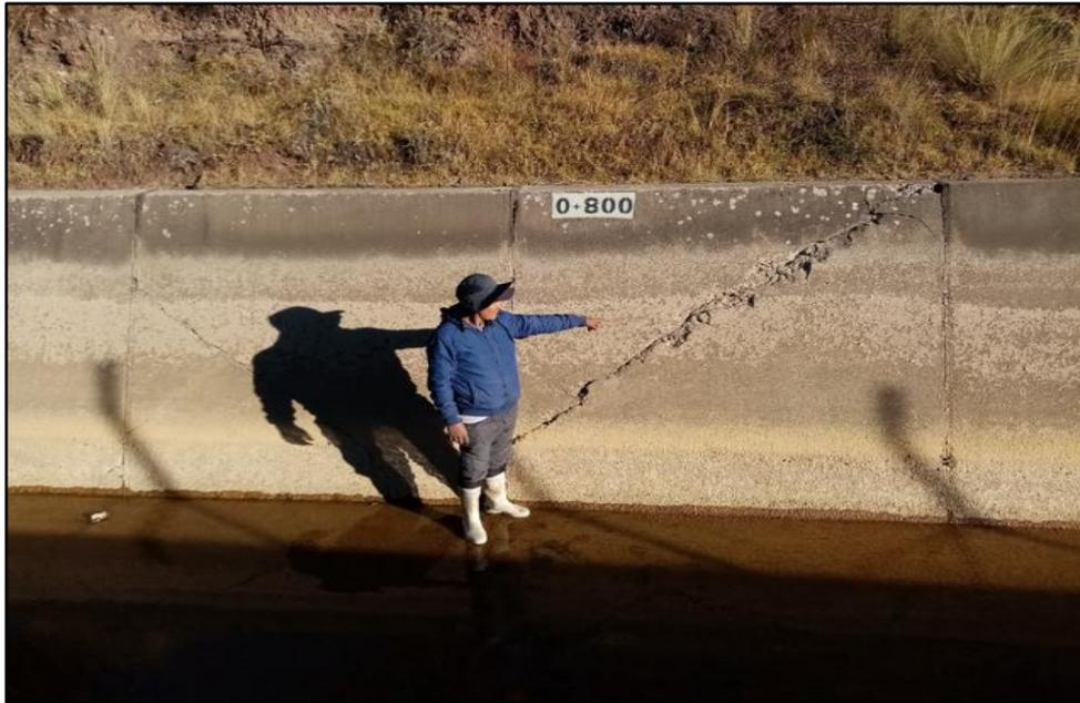
**Figura 8.** Canal alimentador con deficiencias en mantenimiento.
