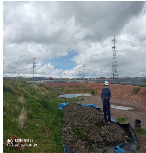
*Figura 02.* Secado de lodo a temperatura ambiente
