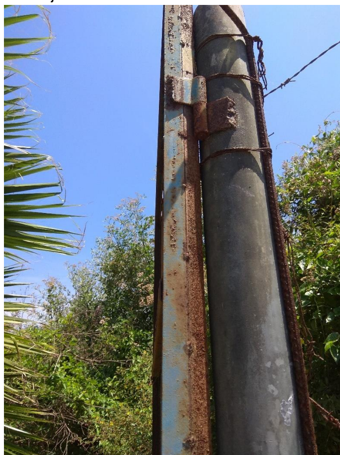
Fotografía N° 10 – Oxido y deterioro en las puertas de acceso a la PTAP
