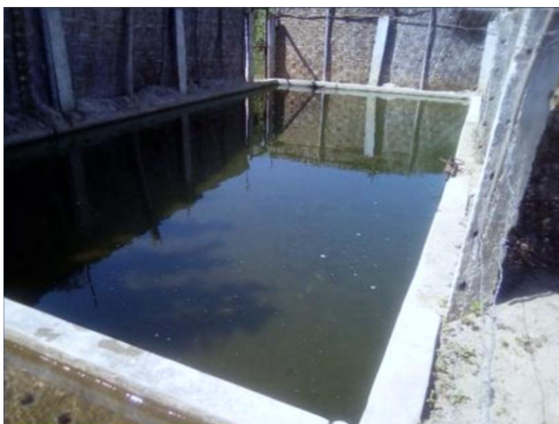
Figura 7 - Presedimentador – PTAP Yaután
