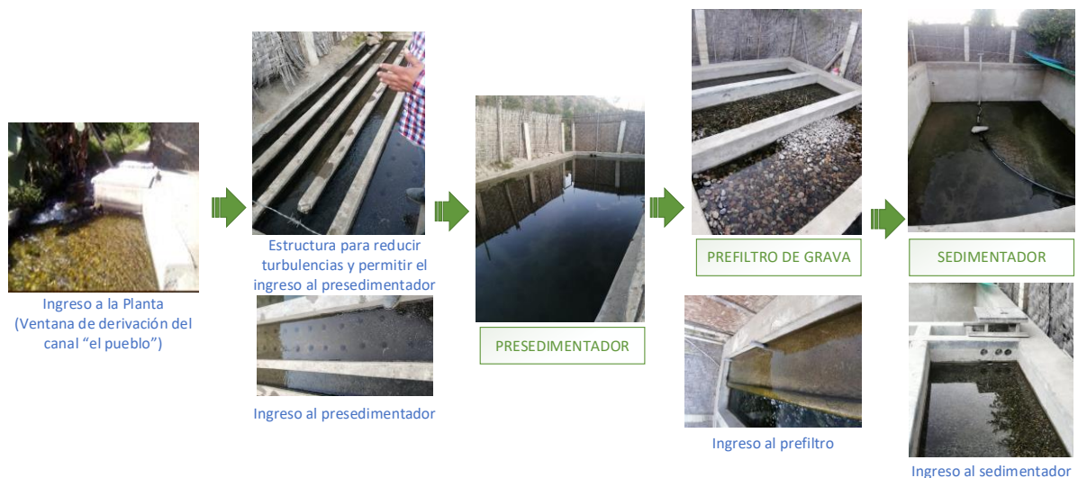
Figura 3 - Unidades que componen la planta de tratamiento de Yaután
