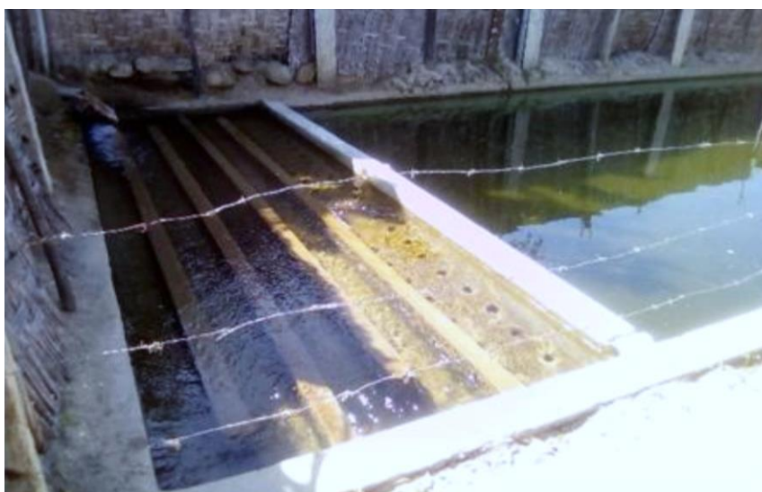
Figura 6 - Estructura de ingreso al presedimentador – PTAP Yaután
