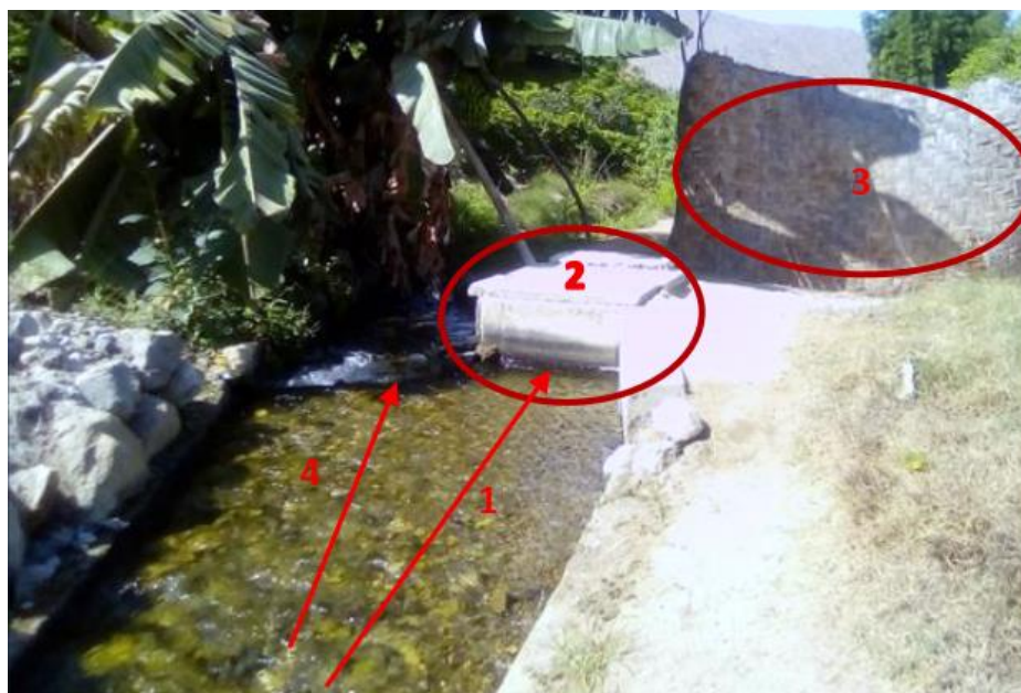
Figura 5 - Captación existente – PTAP Yaután
