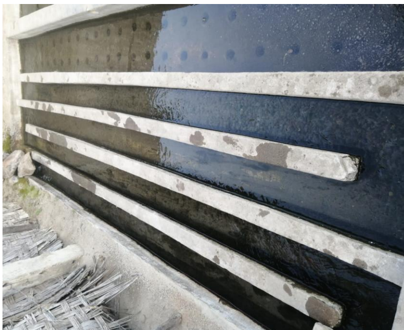
Fotografía N° 01 – Ingreso a la PTAP, amortiguador improvisado, uniformiza el ingreso
