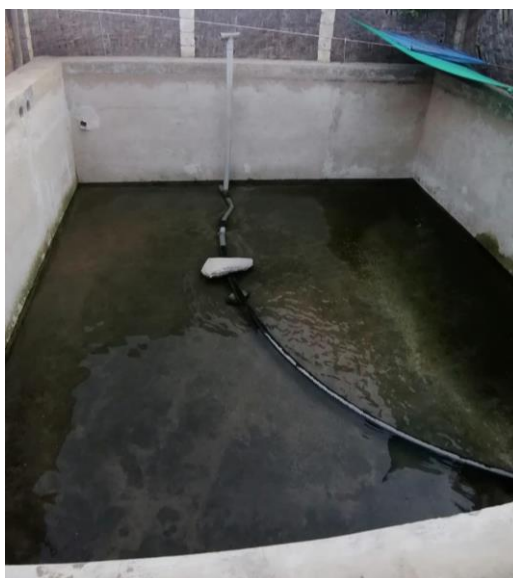
Figura 9 - Sedimentador vacío por mantenimiento – PTAP Yaután
