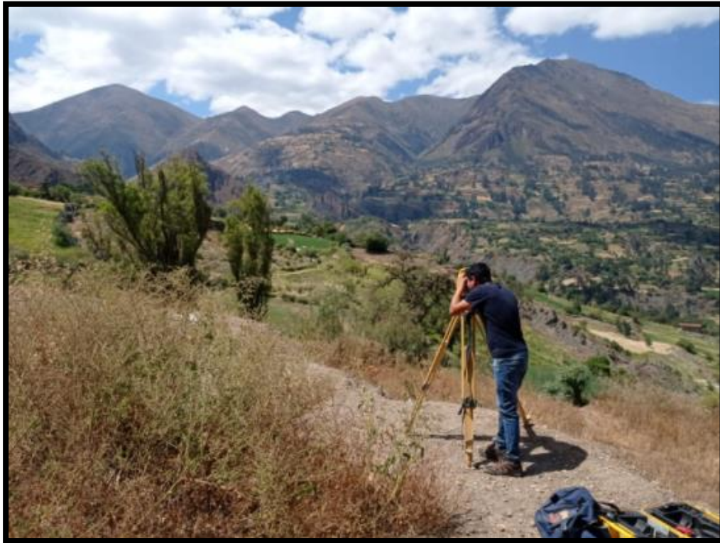
FOTOGRAFIA 04. Se muestra en las fotografías 01,02,03 y 04, el levantamiento con estación total de las viviendas y línea de conducción que se proyectara para el diseño del nuevo proyecto
