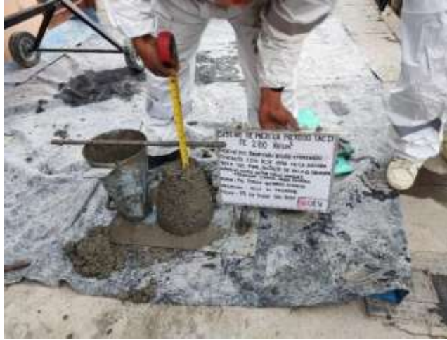
Figura 24 Concreto patrón SLUMP
