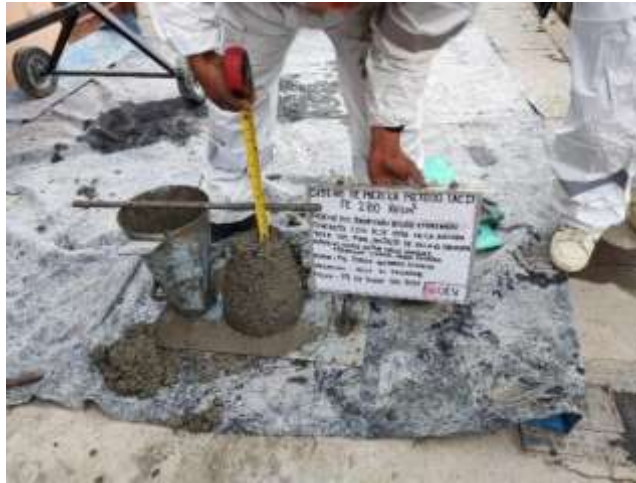
Figura 24 Concreto patrón SLUMP
