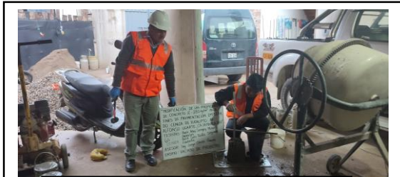
MEDIDA DE SLUMP
