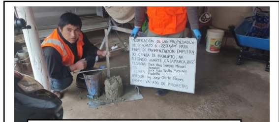
MEDIDA DE SLUMP
