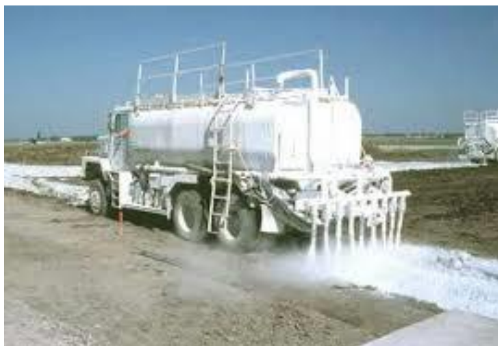
Figura 4. Suelo estabilizado con cal
