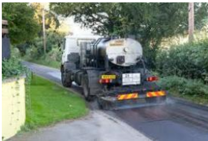
Figura 6. Emulsión asfáltica aplicado al suelo
