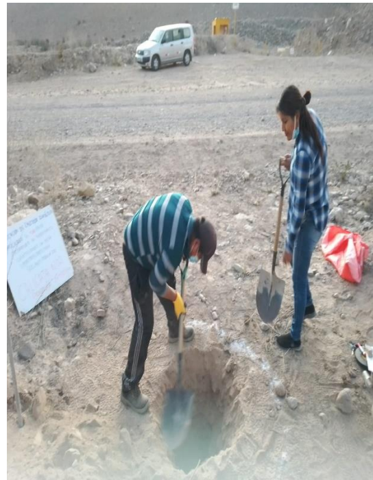
Fotografía 6. Exploración a 0.60 m en la calicata N°01.
