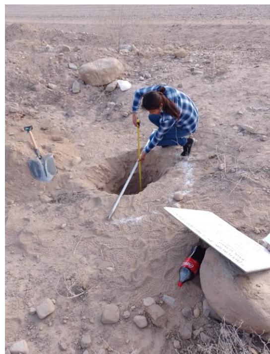
Fotografía 8. Exploración a 1.30 m en la calicata N°01.
