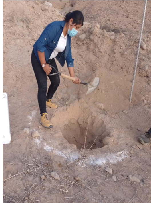
Fotografía 10. Exploración a 1.10 m en la calicata N°02.
