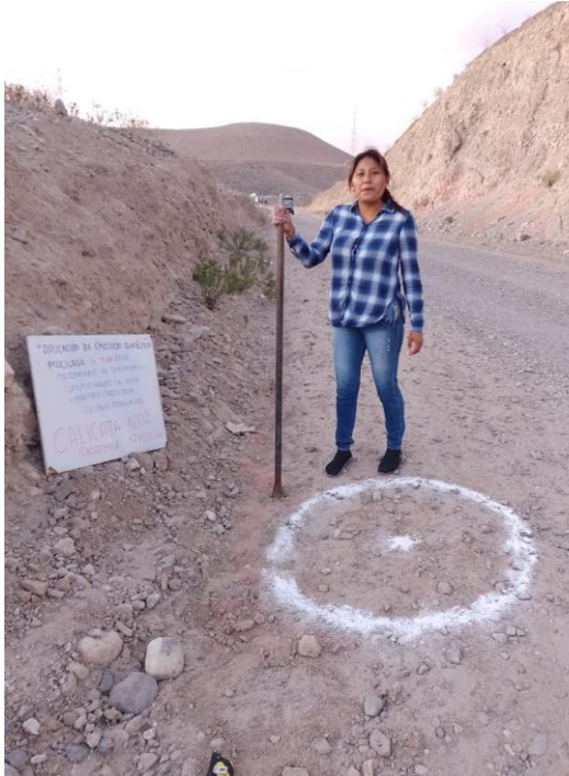
Fotografía 9. Demarcación de la calicata N°02 en el km 17+000
