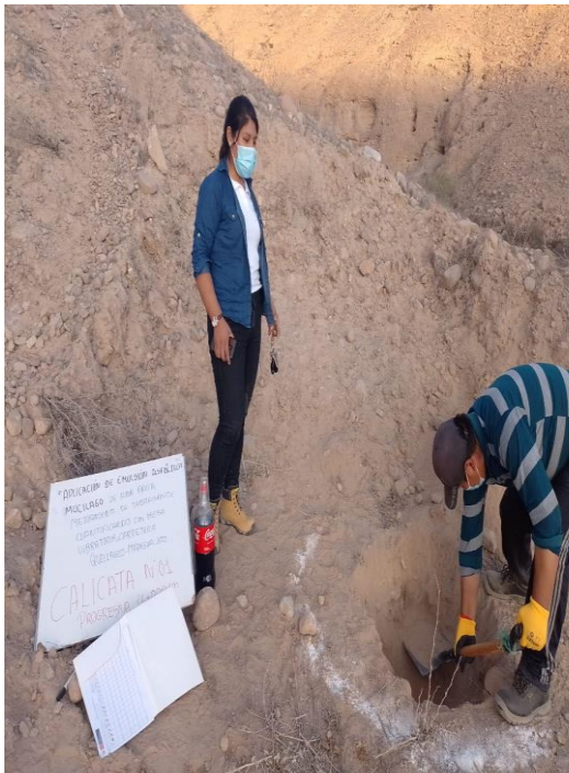
Fotografía 5. Exploración a 0.35 m en la calicata N°01.
