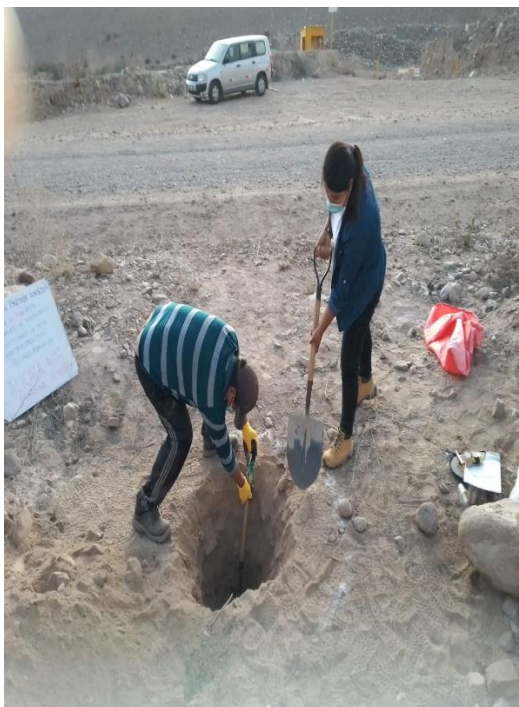
Fotografía 7. Exploración a 1.10 m en la calicata N°01.
