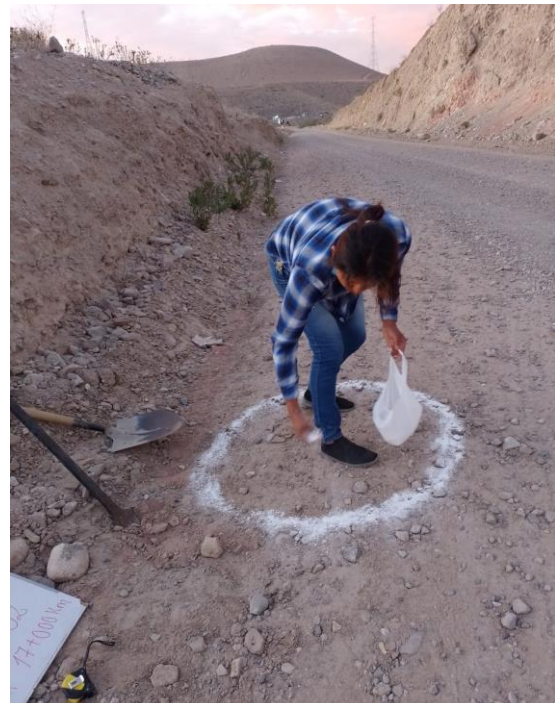
Fotografía 4. Demarcación de la calicata N°02 en el km 17+000
