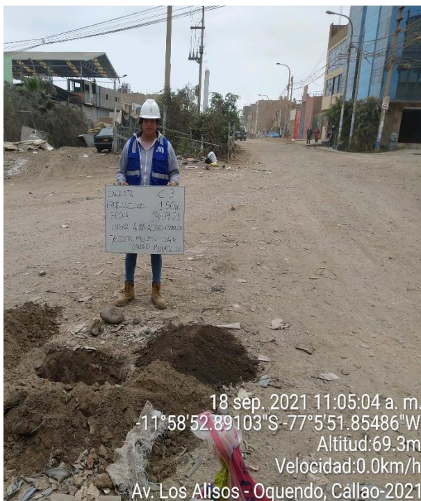
Foto 3: Extracción de la calicata 03
