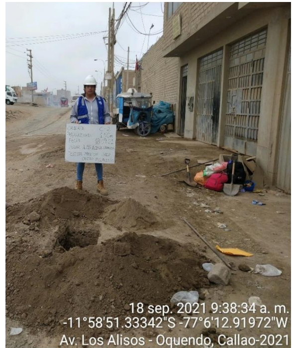
Foto 2: Extracción de la calicata 02
