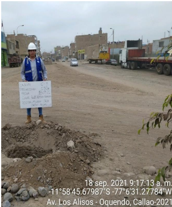
Foto 1: Extracción de la calicata 01
