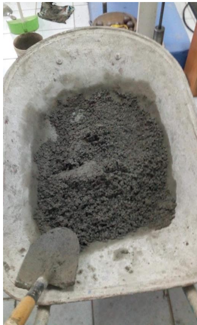
Figura 22: Mezcla para la elaboración de ladrillos
