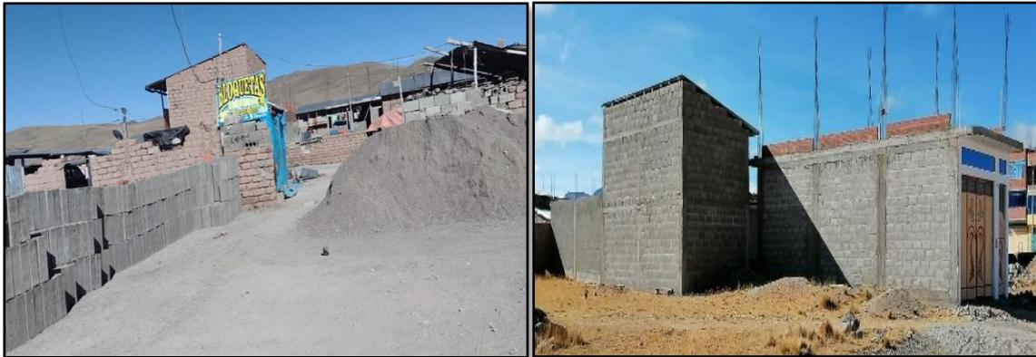
*Figura 1.* Bloquetera artesanal y vivienda construida con bloque de concreto
