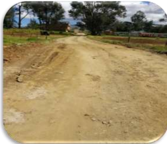
Figura 20: Estado del tramo Pinar-Marian
