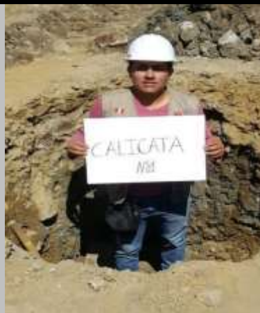
Foto 2. Excavación para extracción de muestra calicata 01 (C-01)
