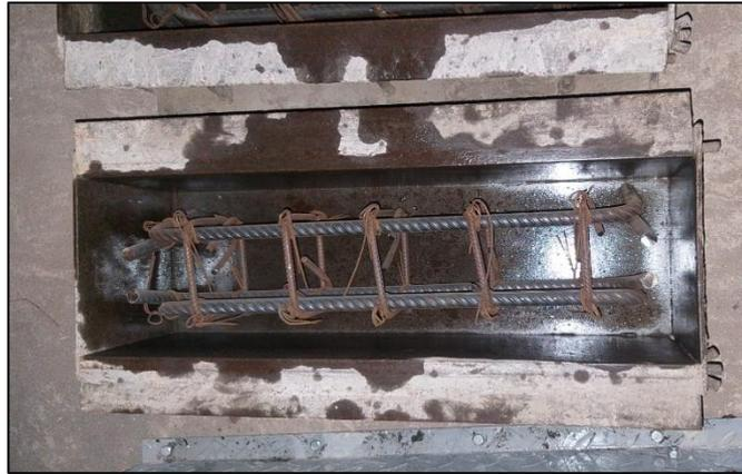
Figura 13. Desmoldante colocado en el molde
