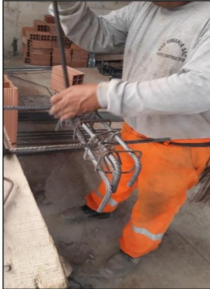
Figura 12. Fabricación de la armadura
