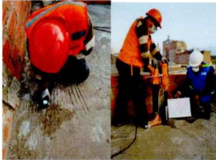
FOTO N°1: EXTRACCIÓN DE UNA DE LAS MUESTRAS DE NÚCLEO DE CONCRETO
