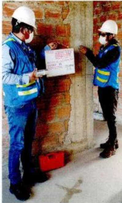
FOTO N°1: TRATANDO SUPERFICIE CON PIEDRA ABRASIVA
