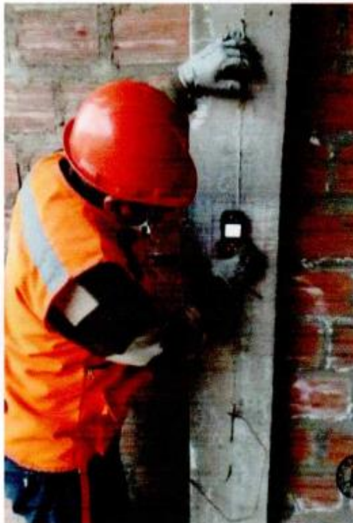
FOTO N°2: PROCEDIMIENTO DE VERIFICACIÓN DE ELEMENTO FERROSO EN ELEMENTO ESTRUCTURAL
